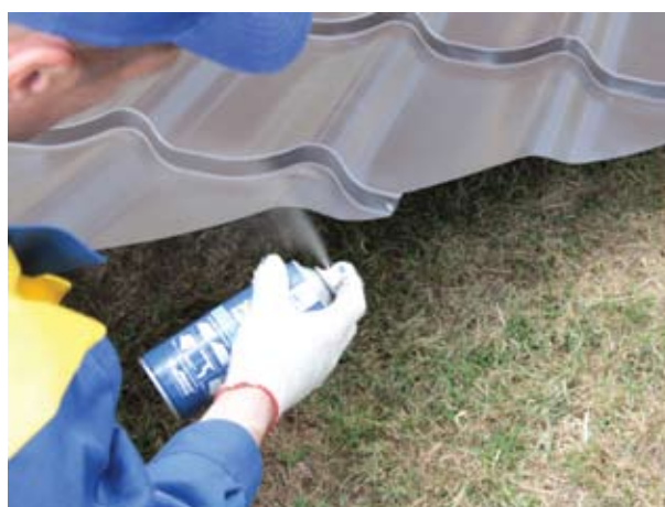
Специальная ремонтная эмаль – защитит обрезные кромки, устранит царапины, потертости, сколы при монтаже.
