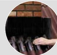
**3** – Укладываем вокруг трубы на стыке трубы с кровлей предварительно согнутую углом полосу ОНДУФЛЕШ-СУПЕР. Завальцовываем края полученного шва.
