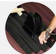
**2** – Труба устанавливается на основание вертикально и фиксируется пластиковыми шпильками.
