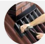
**2** – Отмеряем длину ОНДУФЛЕШ-СУПЕР шире печной трубы. Приклеиваем поверх фартука полосу ОНДУФЛЕШ-СУПЕР. Свободные края ленты отгибаем от печной трубы.
