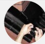
**4** – Стык полосы ОНДУФЛЕШ-СУПЕР фиксируется металлическим профилем. Фиксация производится по всему периметру саморезами.
