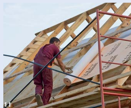
11. Поверх утеплителя уложили ветровлагозащитную супердиффузионную мембрану, закрепив её с помощью контрбруса
