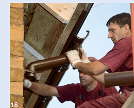
18. После установки пластиковых желобов смонтировали водоприёмную воронку и водосточные трубы
