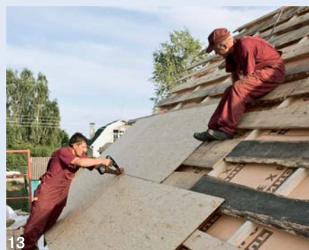
13. Подготовка основания, для которого использовали ориентированные древесно-стружечные плиты
