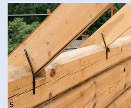
5. С помощью металлических скоб все стропильные ноги надёжно закрепили к коробке дома
