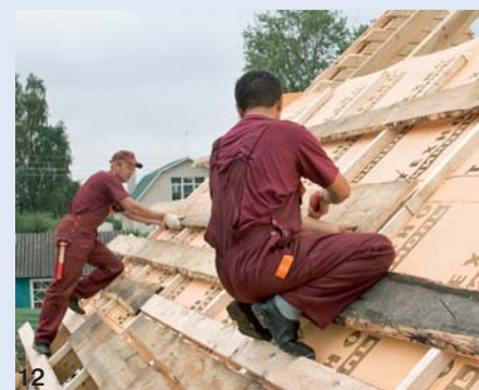
12. Монтаж обрешётки из обрезной доски. Величина вентзазора была задана высотой контрбруса — 50 мм
