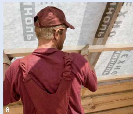
8. Для крепления пароизоляционной мембраны «ТехноНИКОЛЬ» к стропильным ногам использовали контрбрус
