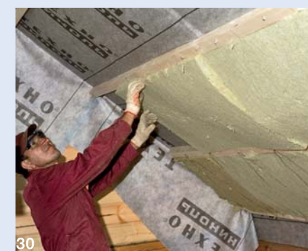
30. Завершающий этап — монтаж четвёртого слоя утеплителя и фиксация его металлической проволокой
