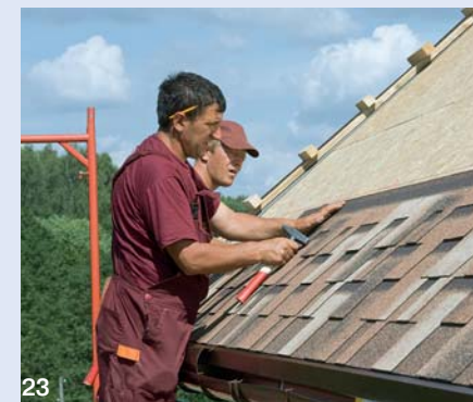
23. Каждый лист крепили четырьмя гвоздями так, чтобы гвоздь прошивал и верхний край нижележащего листа черепицы
