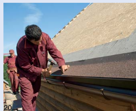
20. При монтаже коньково-карнизной черепицы делают отступ от перегиба капельника на 0,5–1 см
