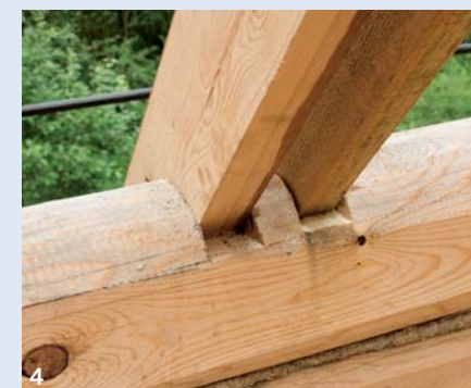
4. Слабую стропильную систему решено было усилить путём добавления второй стропильной ноги
