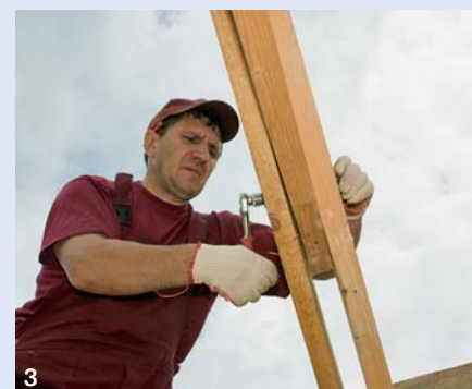
3. Процесс закрепления затяжек к стропилам при помощи специальных болтовых соединений
