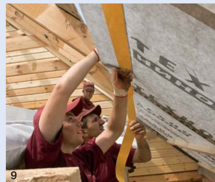
9. Швы пароизоляции соединили бутилкаучуковой лентой (двусторонний строительный скотч)
