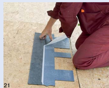
21. Плитки SHINGLAS имеют самоклеющийся слой, защищённый легкосъёмной силиконизированной плёнкой
