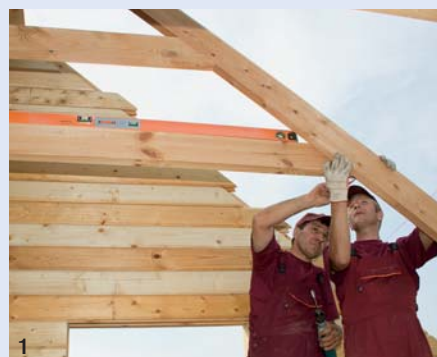
1. Согласно п. 2.43 СНиП 3.04.01-87 допустимое отклонение поверхности по горизонтали должно составлять ± 5 мм
