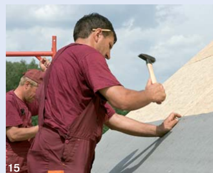
15. Подкладочный гидроизоляционный ковёр зафиксировали на основании кровельными гвоздями с интервалом 20 см
