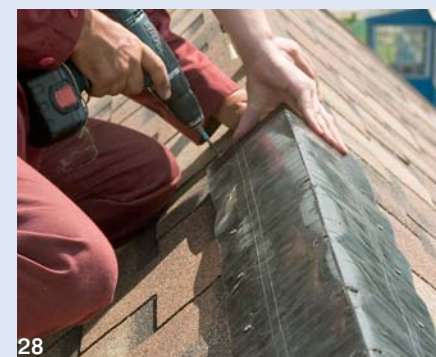
28. Монтаж конькового вентиляционного элемента, обеспечивающего оптимальный температурно-влажностный режим
