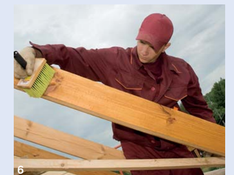
6. В конце подготовительных работ стропила и затяжки тщательно, в два слоя, покрыли огнебиозащитным составом
