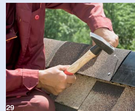
29. Коньково-карнизную черепицу смонтировали поверх вентиляционного элемента, зафиксировав её гвоздями
