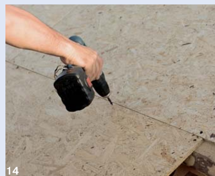
14. Плиты уложили вразбежку, оставив зазоры по 3 мм на температурное расширение, и прикрепили саморезами
