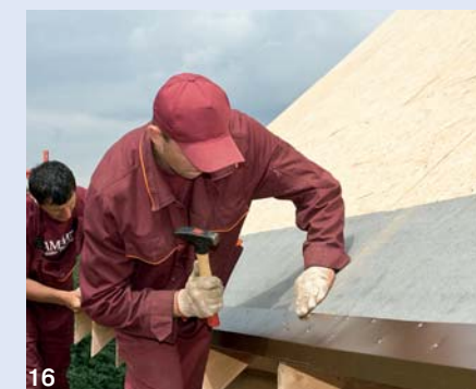
16. Свесы кровли защитили карнизными планками, укрепив кровельными гвоздями в шахматном порядке с шагом 15 см
