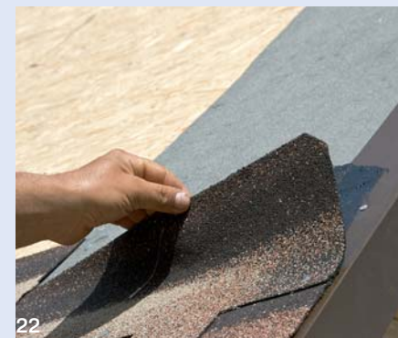
22. Уголок у рядовой черепицы подрезается в каждом ряду на 2–3 см. Это необходимо для отбоя воды
