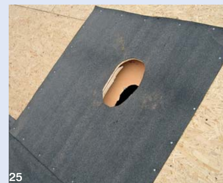
25. В основании кровли прорезали отверстие, вокруг которого уложили выкройку из подкладочного ковра
