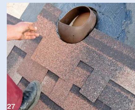
27. Ряды битумной черепицы снизу вверх уложили на «проходку» и приклеили к фланцу битумной мастикой
