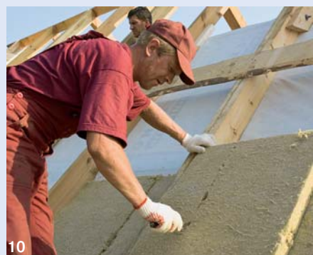
10. Для обеспечения надёжной теплозащиты листы утеплителя «ТЕХНОЛАЙТ» клали плотно друг к другу с разбежкой швов
