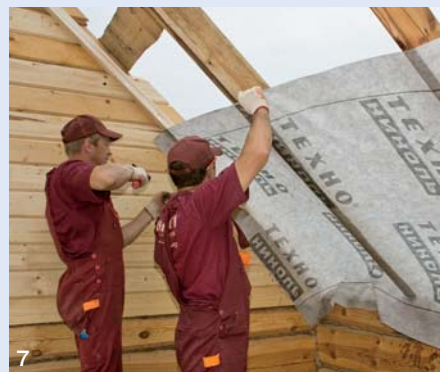
7. Монтаж пароизоляционной плёнки, обеспечивающей сохранение теплоизоляционных свойств утеплителя
