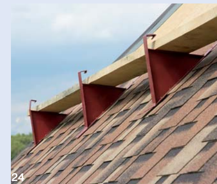
24. Для удобства монтажа гибкой черепицы рабочие использовали специальные металлические консоли
