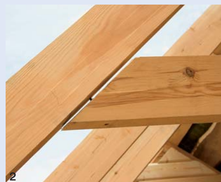
2. Неправильно выполненное соединение деревянных затяжек со стропильными ногами
