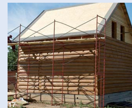
17. Полосы подкладочного гидроизоляционного ковра шириной 50 см уложили по периметру ската
