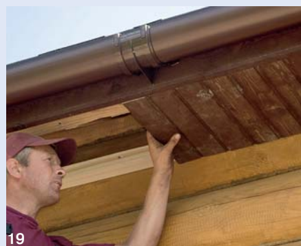
19. Для оформления карнизных свесов использовали вагонку, пропитанную биовлагозащитным составом
