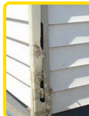
Термическая деформация, разрушение элементов отделки
