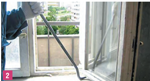
Освобождение старой оконной рамы
