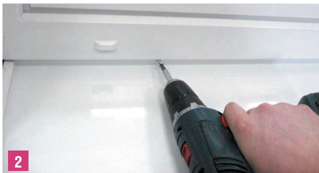
Установка отливов
