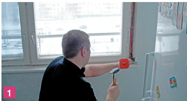
Демонтаж отливов и подоконников
